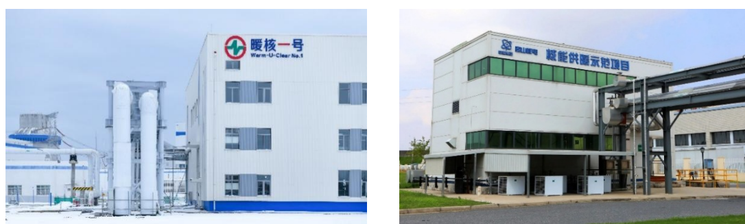
图 2-5 山东海阳、浙江秦山核电供暖项目
