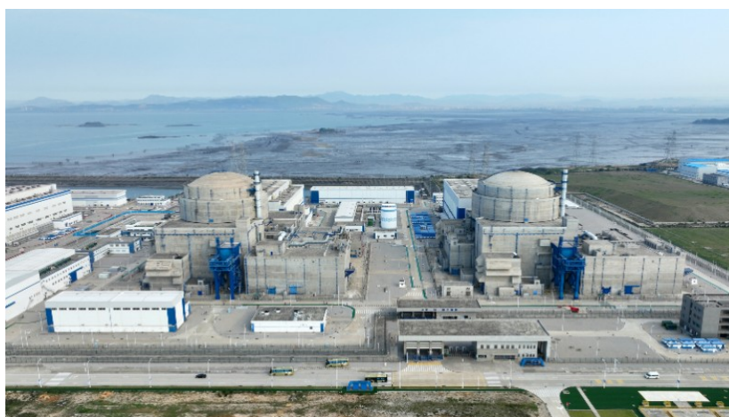
图 1-4 “华龙一号”示范工程福建福清核电 5、6 号机组
